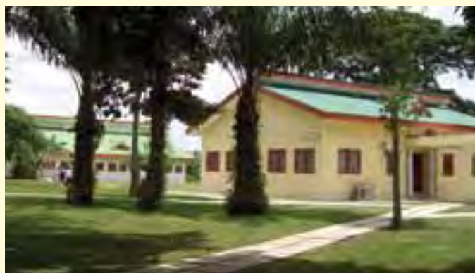
Il Centro di Formazione Missionaria ad Abidjan
